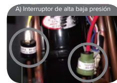
A) Interruptor de alta baja presión Interruptor de baja presión Interruptor de alta presión
