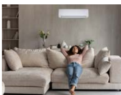
Frío/Calor con Fan Coils
